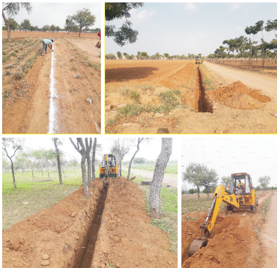
चित्र 1.3 संस्थान में जल निकास मार्ग चैनल का रेखांकन और निर्माण Fig. 1.3 Layout making and construction of drainage pathway channel in the institute
